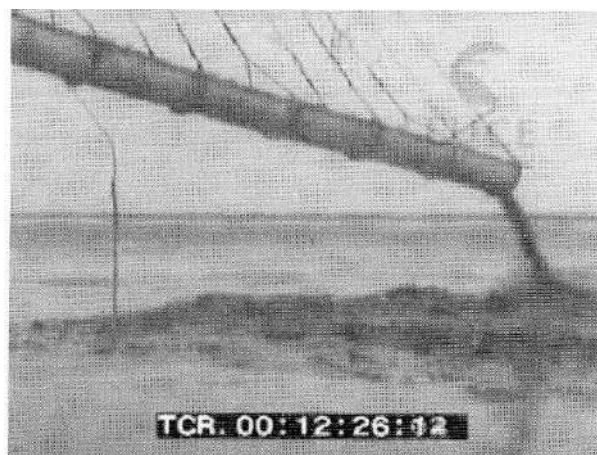
Figura II.I.5 – 3 - Comacchio (FE) 1953: sistemi di scarico delle attività di bonifica (Guzzon 2017).
