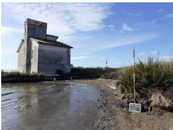
Figura II.I.2 - 2 – Comacchio, Valle Fossa di Porto, Casone Garibaldi (foto: G. Bucci).
