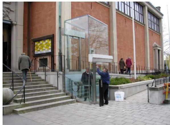
**Fig.1 & 2.** Dal confronto delle due immagini è possibile verificare quanto sia contenuto l'impatto dell'intervento di installazione di una rampa di accesso e di un elevatore protetto in corrispondenza dell'entrata principale della Liljevalchs konsthall di Stoccolma. La rampa si cela per mimesi dei materiali, mentre l'elevatore contiene il proprio impatto visivo grazie all'uso di cristallo extra trasparente.
