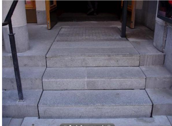
**Fig.5.** Un principio simile è applicato sulla gradinata di accesso alla Folkoperan, il Teatro Popolare dell'Opera di Stoccolma, in cui ogni singolo gradino, completo di rivestimento in pietra, è mobile in modo indipendente. Traslando verticalmente, i gradini costituiscono una pedana elevatrice. In fase di riposo, l'unica differenza, appena percepibile, tra lo stato originale e quello attuale è la fessura perimetrale che circonda i gradini mobili.
