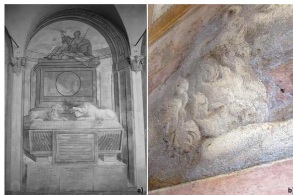
**Fig.5.** Monumento Ignazio Magnani: a) rilievo grafico con indicazione delle incisioni quale tecnica di riporto del disegno; b) tracce di tecnica trasposizione del disegno (luce radente).
