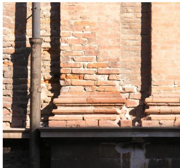
Fig.4. Dettaglio dello stato conservativo del paramento murario in laterizio.
