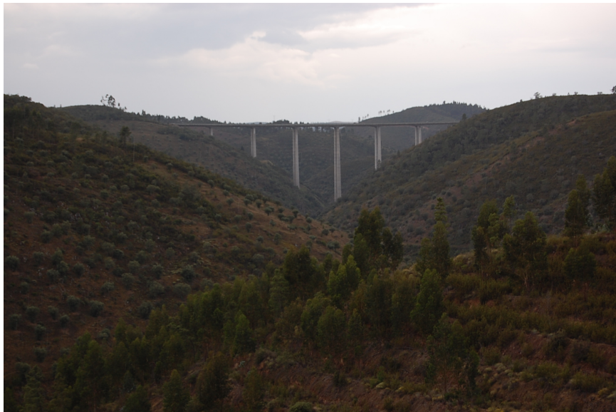
Fig.2. Auto-Estrada A23, ponte sobre o Rio Tejo, Julho 2009.
