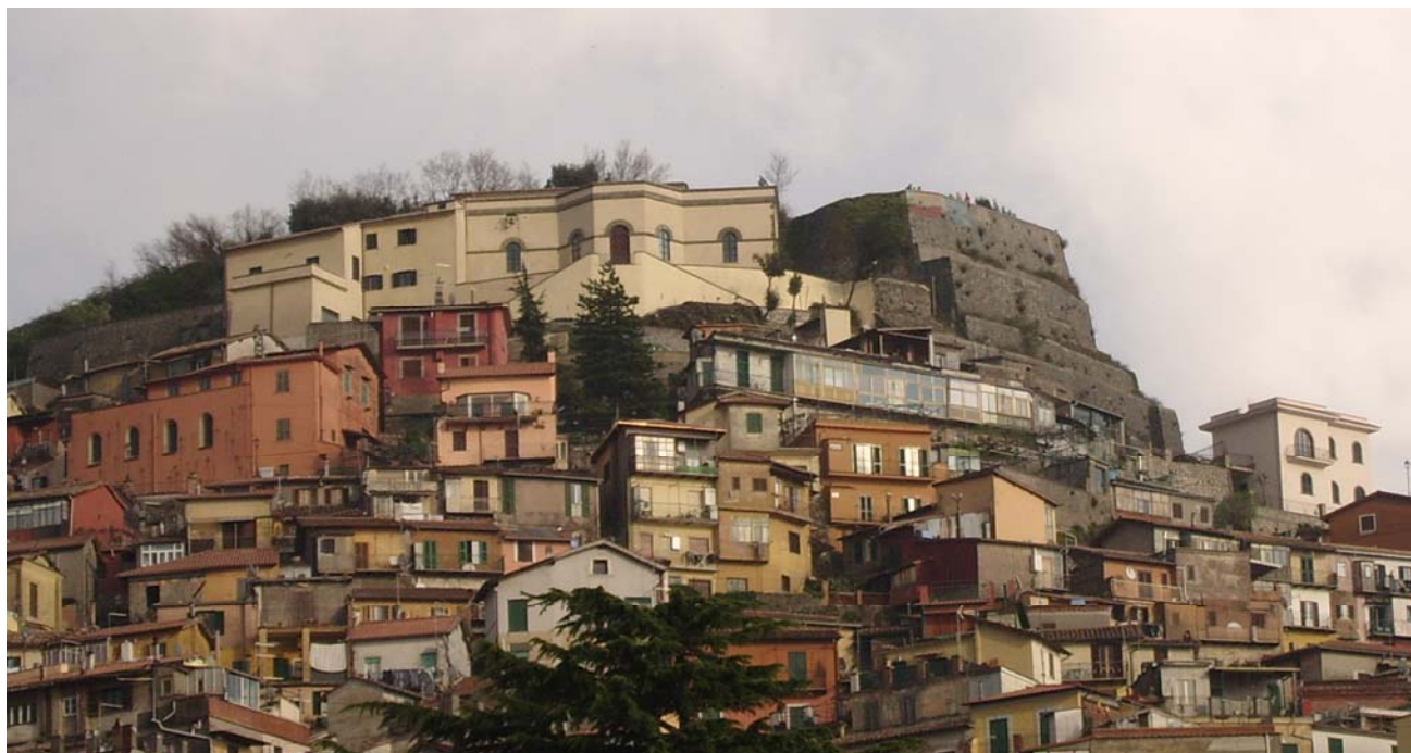
Fig. 1. Il Museo Geofisico, in primo piano, è situato a ridosso dell'antica Fortezza Colonna, in posizione panoramica e dominante sul vecchio centro storico di Rocca di Papa (Roma).
