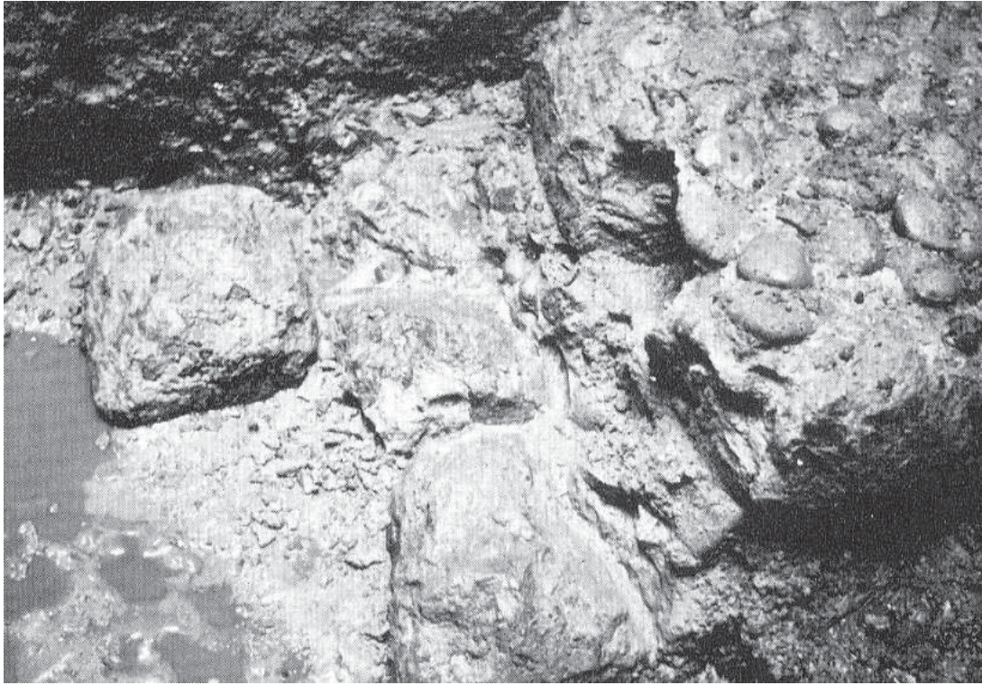
Fig. 3. Casa del Capitano. Fondazione del muro medievale con le basole rovesciate di reimpiego (da Patitucci Uggeri 1974, fig. 10B).
