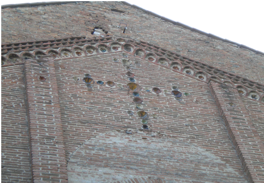
Fig. 65. Part. Facciata della chiesa di S. Bartolo, Ferrara
