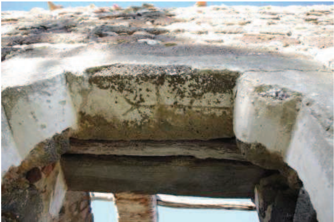
Foto 1.5.4: particolare architrave portale Sud
