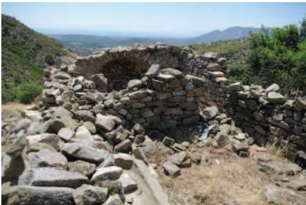
Foto 3.4.5: vista verso abside Sud-Est
