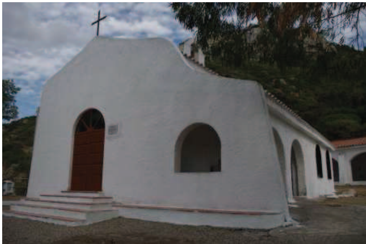
Foto 4.2.1: vista da angolo Ovest
