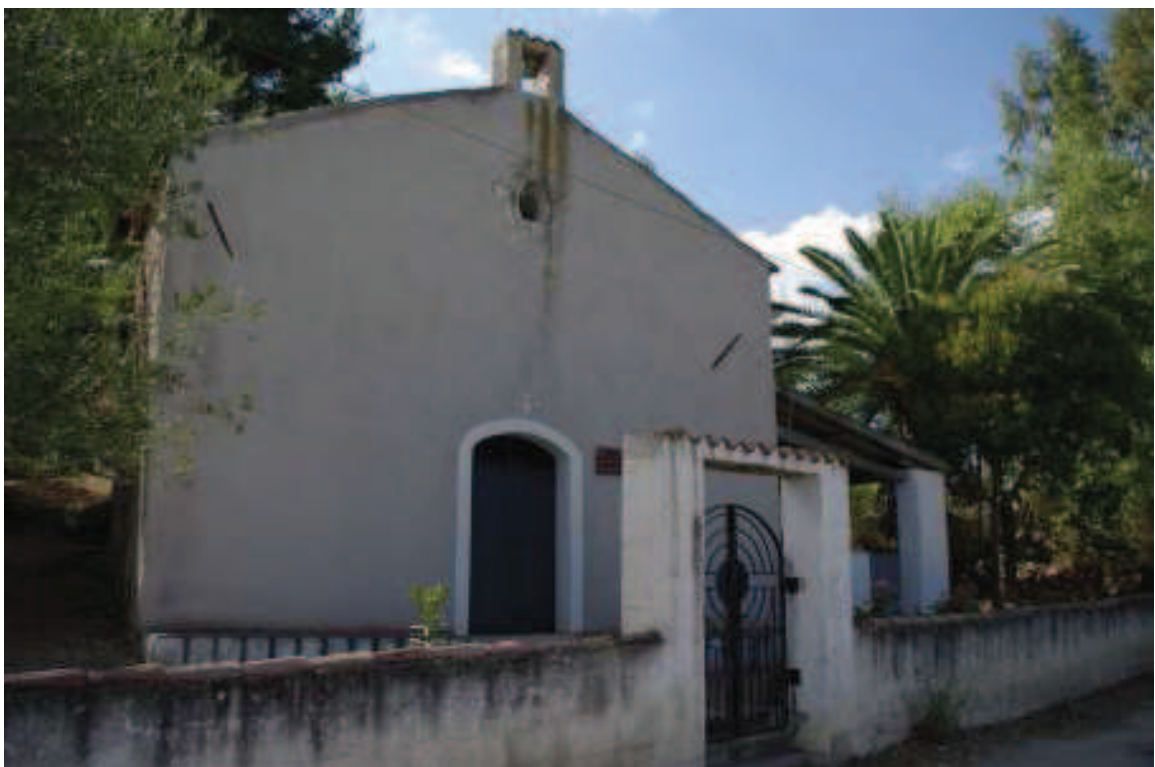
Foto 1.2.2: facciata a Sud-Est
