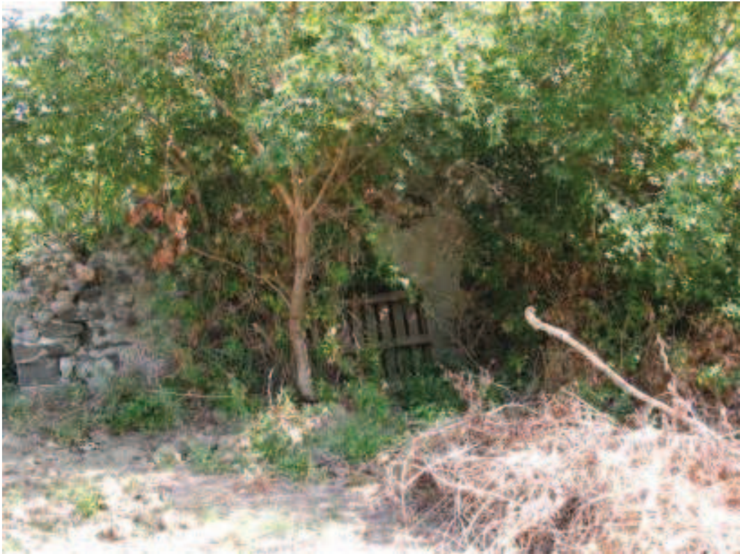
Foto 1.3.1: facciata a Sud-Ovest parzialmente interrata
