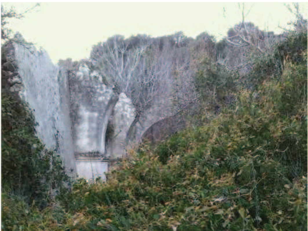
Foto 1.3.2: interno parete Sud Est
