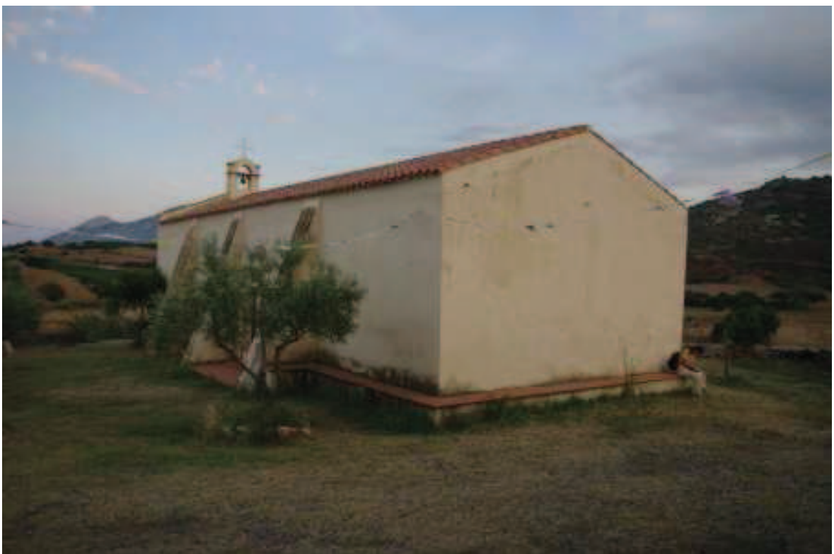
Foto 3.2.4: retro e parete Nord-Est
