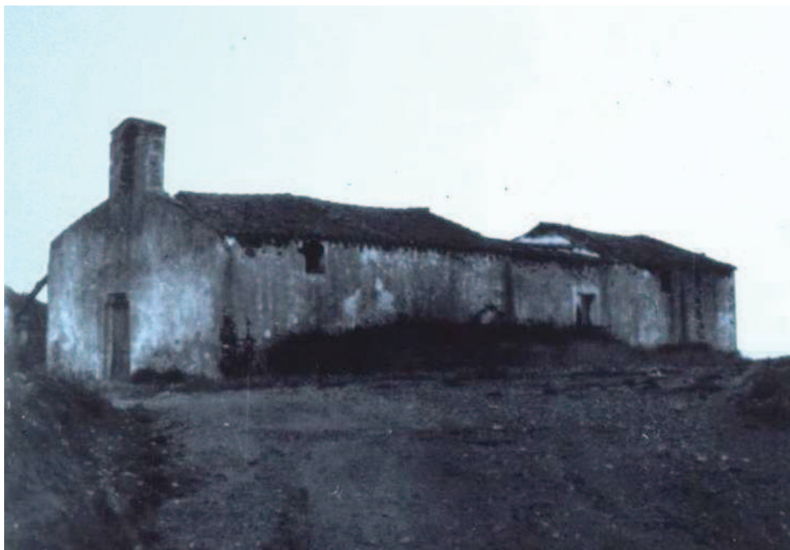
Foto 1.4.3: anni '60, vista Sud-Est (Archivio SBAPSAE Sassari)
