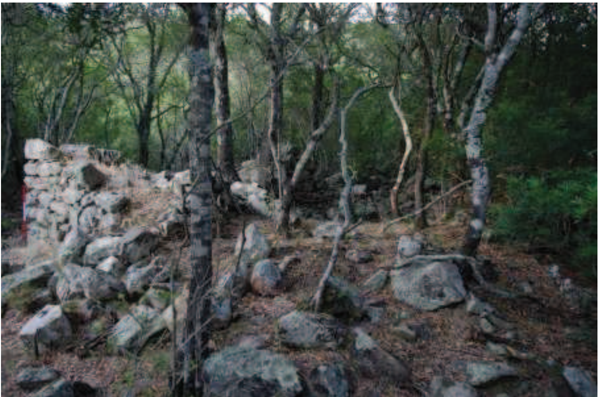
Foto 3.7.4: angolo esterno parete Sud-Est
