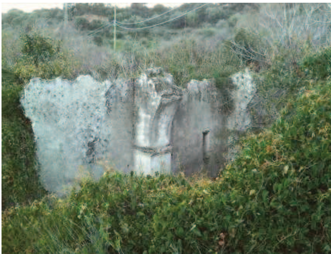
Foto 1.3.3: interno parete Sud Est
