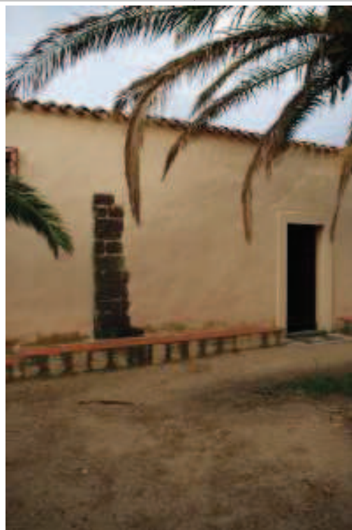
Foto 2-3 A sx, arco nel paramento esterno nord; a dx, muratura risparmiata dall'intonacatura nel paramento esterno sud. Anno: 2013
