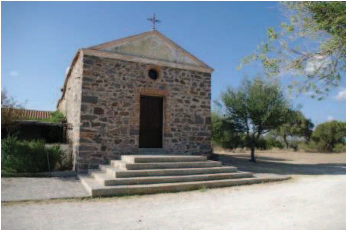
Foto 1.1.1: facciata a Sud-Est
