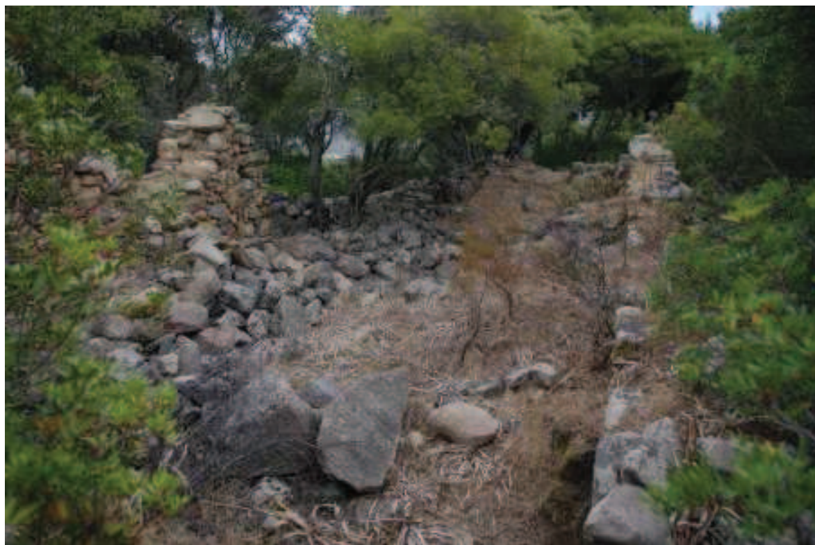
Foto 3.3.2: vista d'insieme da ingresso Nord-Ovest
