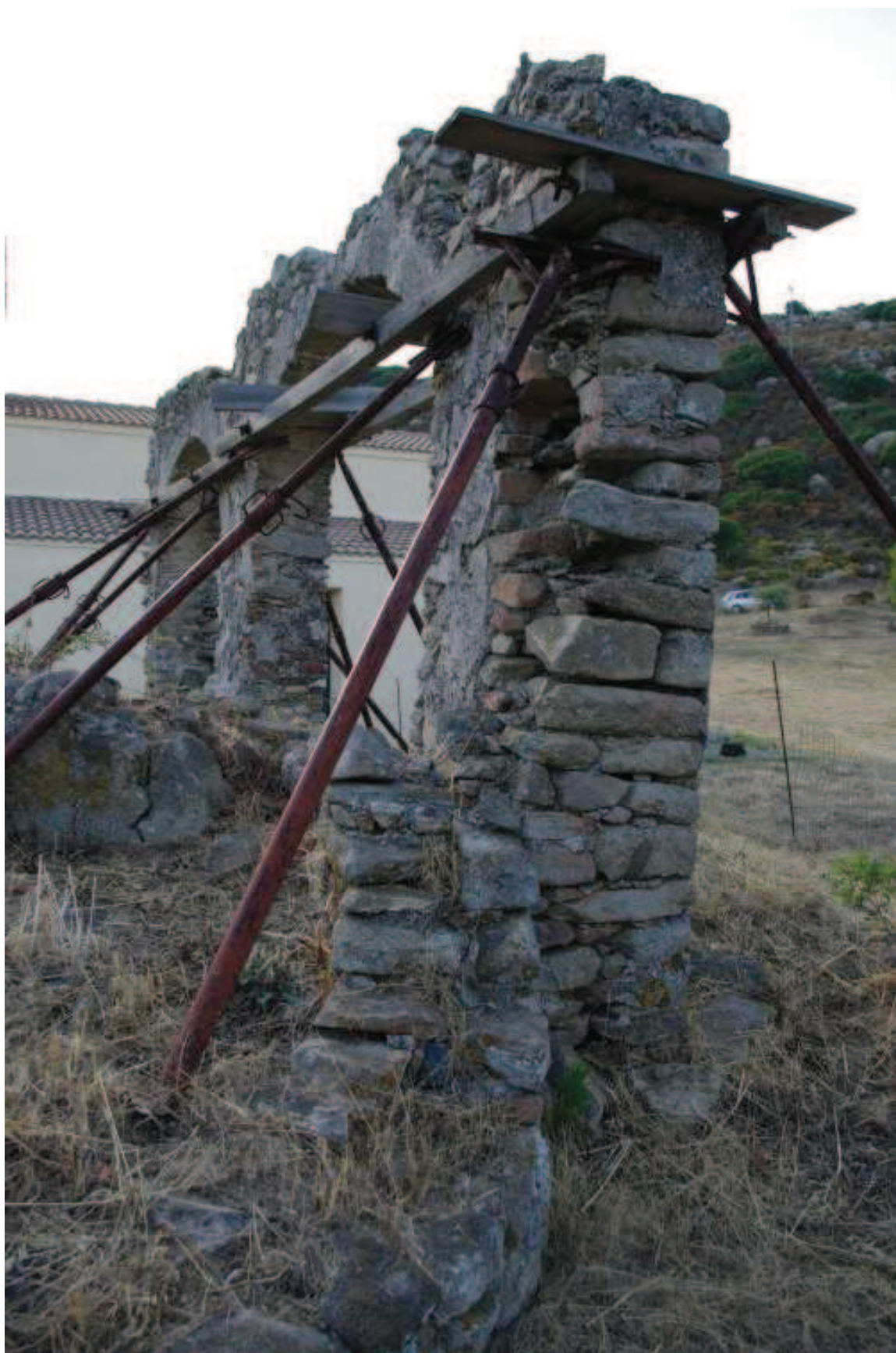
Foto 3.5.3: vista Est, abside
