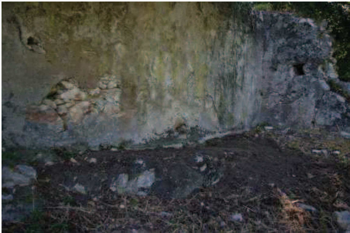
Foto 2.1.1: interno parete Sud
