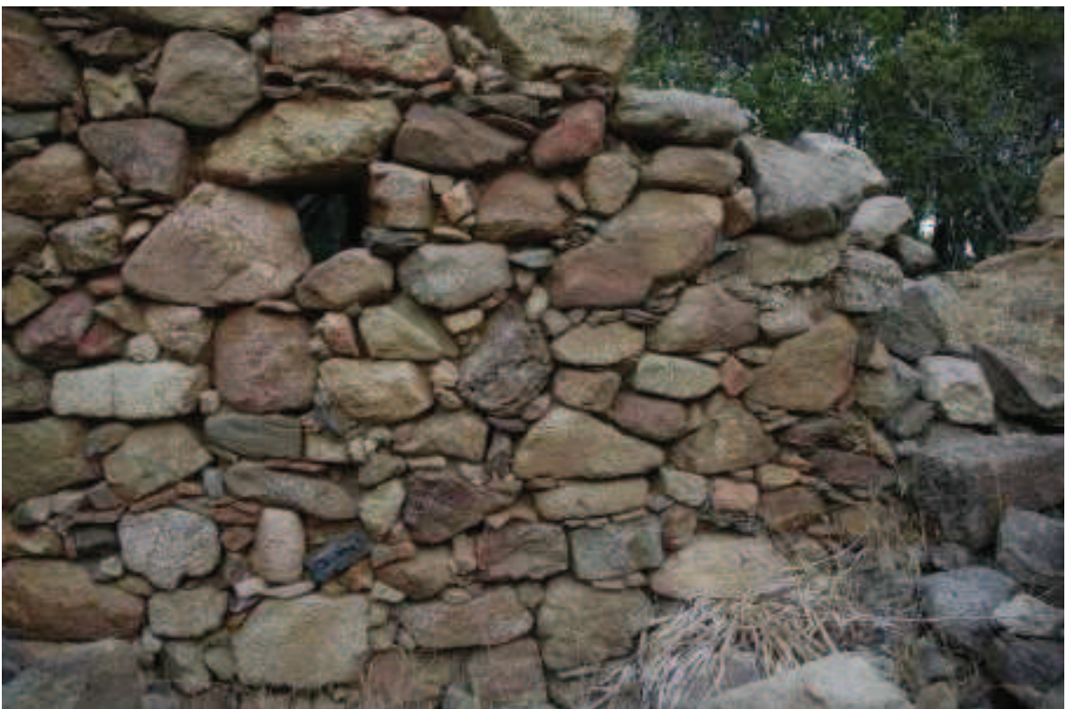
Foto 3.3.4: particolare buca pontaia e zeppature
