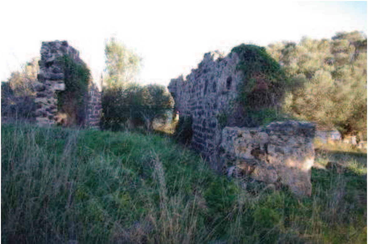
Foto 4.3.3: vista da Ovest (facciata)
