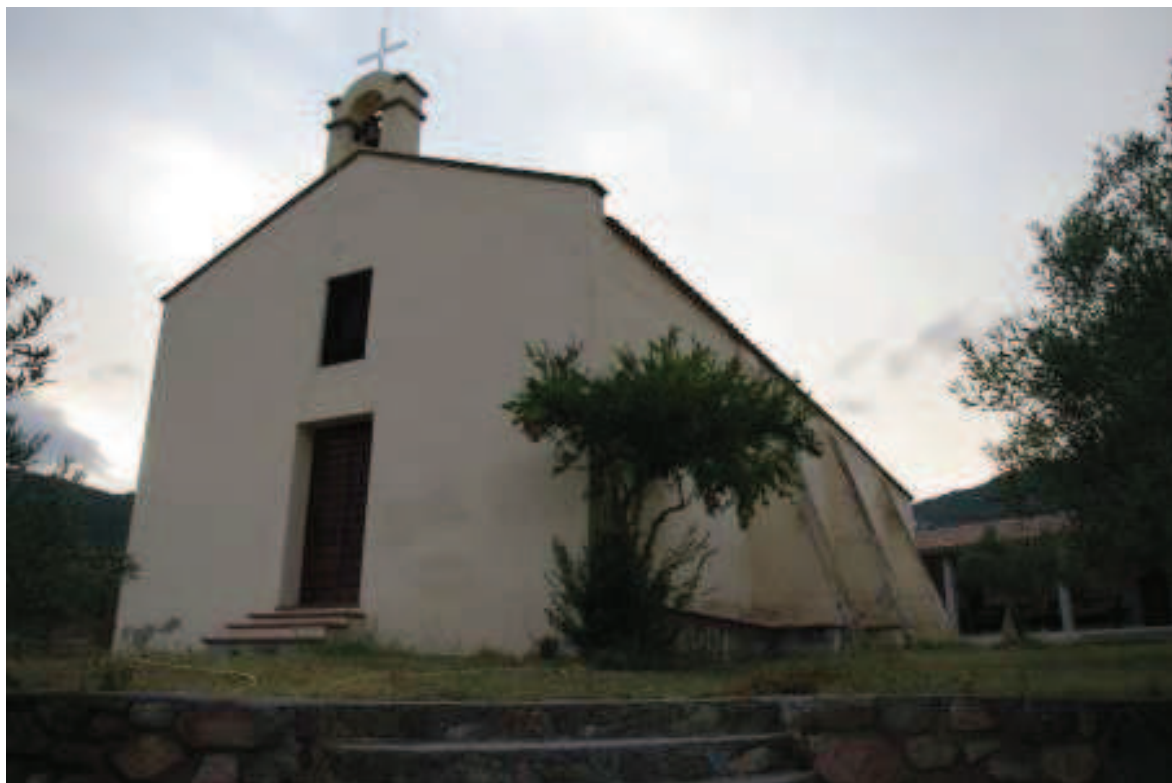
Foto 3.2.1: facciata e parete Nord-Est
