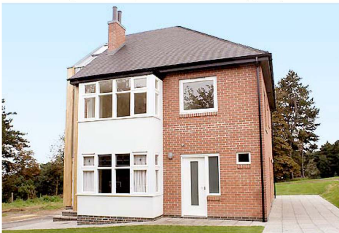
Figura 8.1. La EON House, uno degli edifici residenziali sperimentali costruiti nel campus della University of Nottingham (progetto Creative Energy Homes ). L'edificio è stato oggetto di un test sperimentale per la valutazione della prestazione energetica dell'involucro ( coheating test ).
