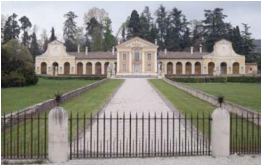
Figura 7.12. Villa Barbaro, Maser (Treviso). L'immagine mostra il fronte principale dell'edificio, caratterizzato dal corpo principale, più alto, con lesene e timpano, nella classica conformazione a tempio, circondato dalle barchesse, i lunghi corpi di servizio ai lati, con portici.
