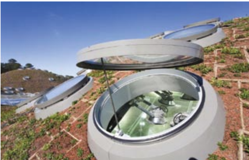
Figura IV.31: Lucernario della copertura
