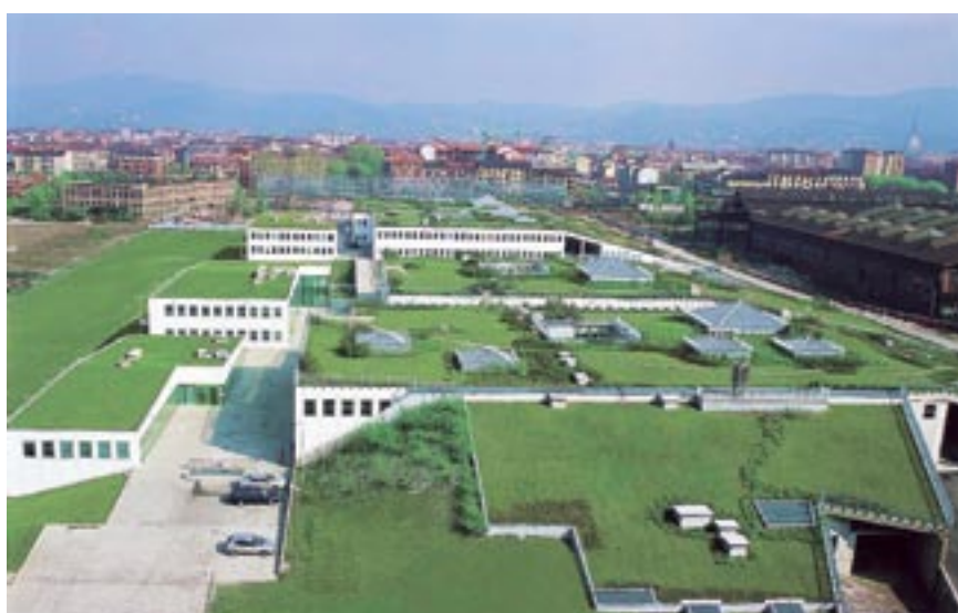
Figura I.29: Vista delle coperture dell'Environment Park
