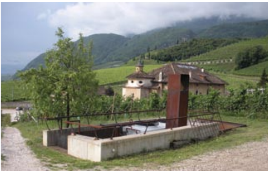
Figura I.67: Presa d'aria della copertura
