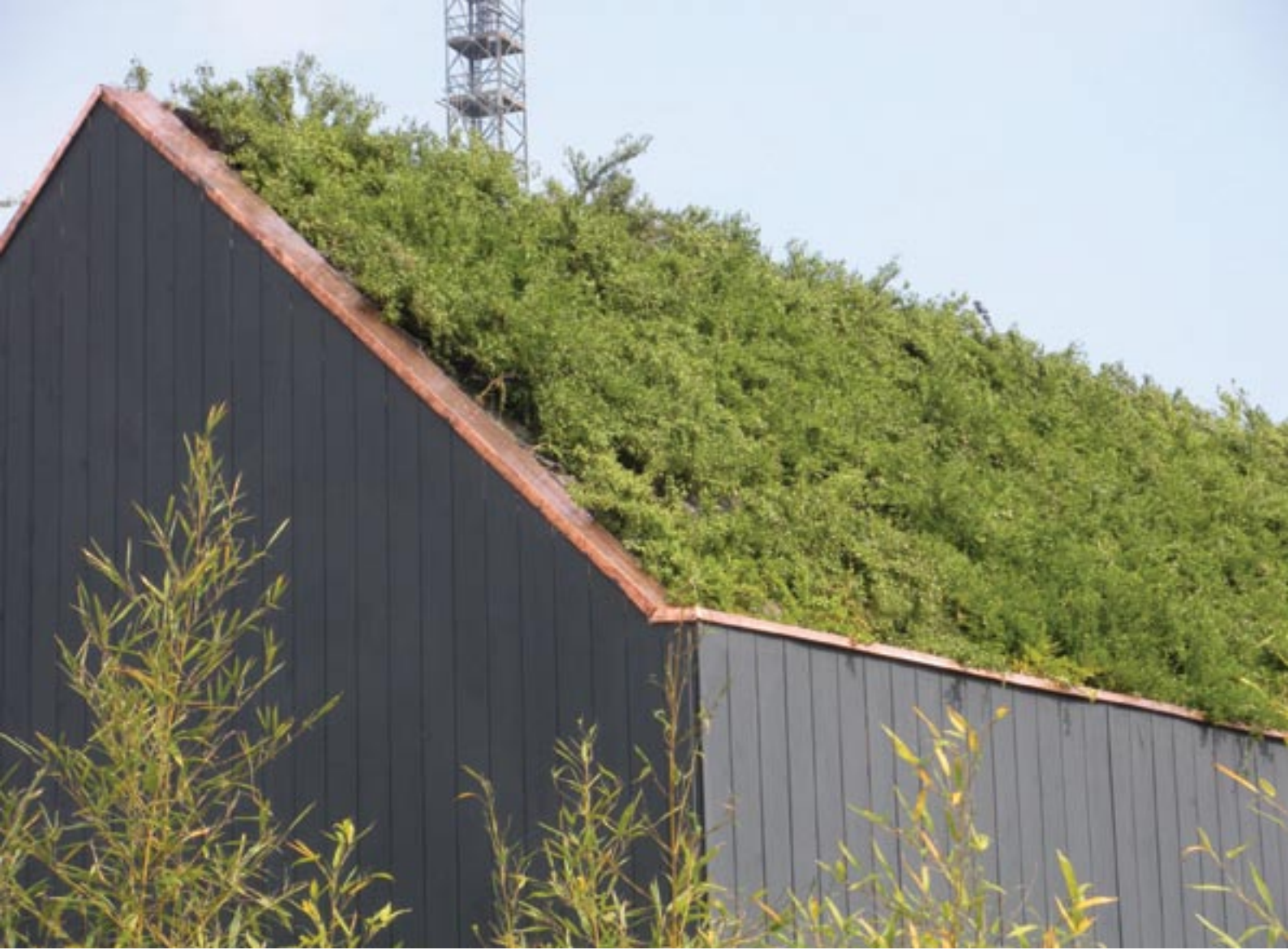
Figura IV.34: Copertura a falde semi-intensiva Fonte: Jacopo Gaspari
