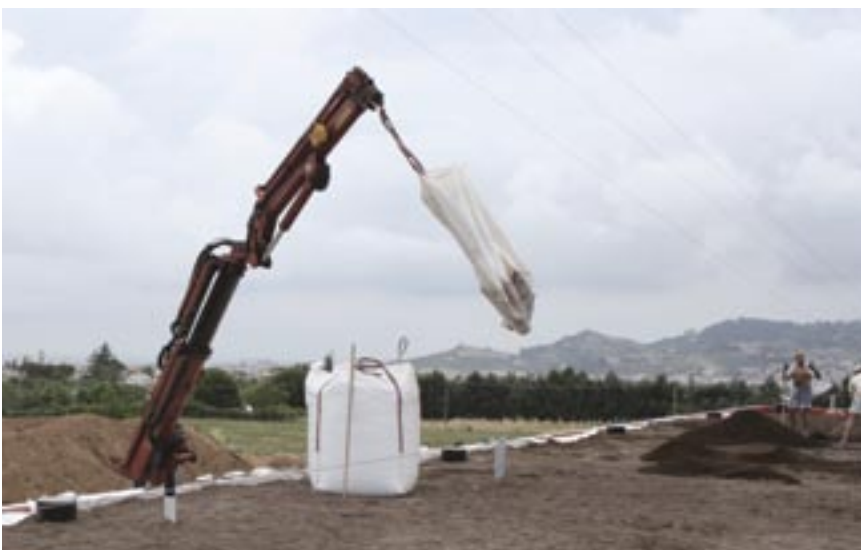
Figura III.5: Applicazione del substrato
