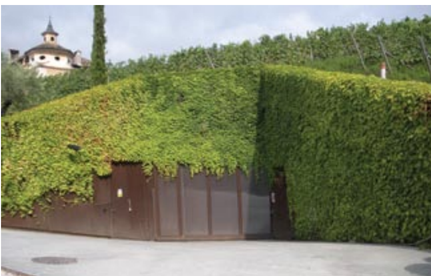
Figura I.68: Uscita di sicurezza
