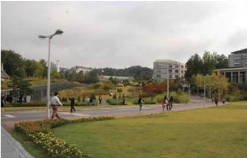
Figura II.32: Vista del braccio est dal giardino pensile del braccio opposto
