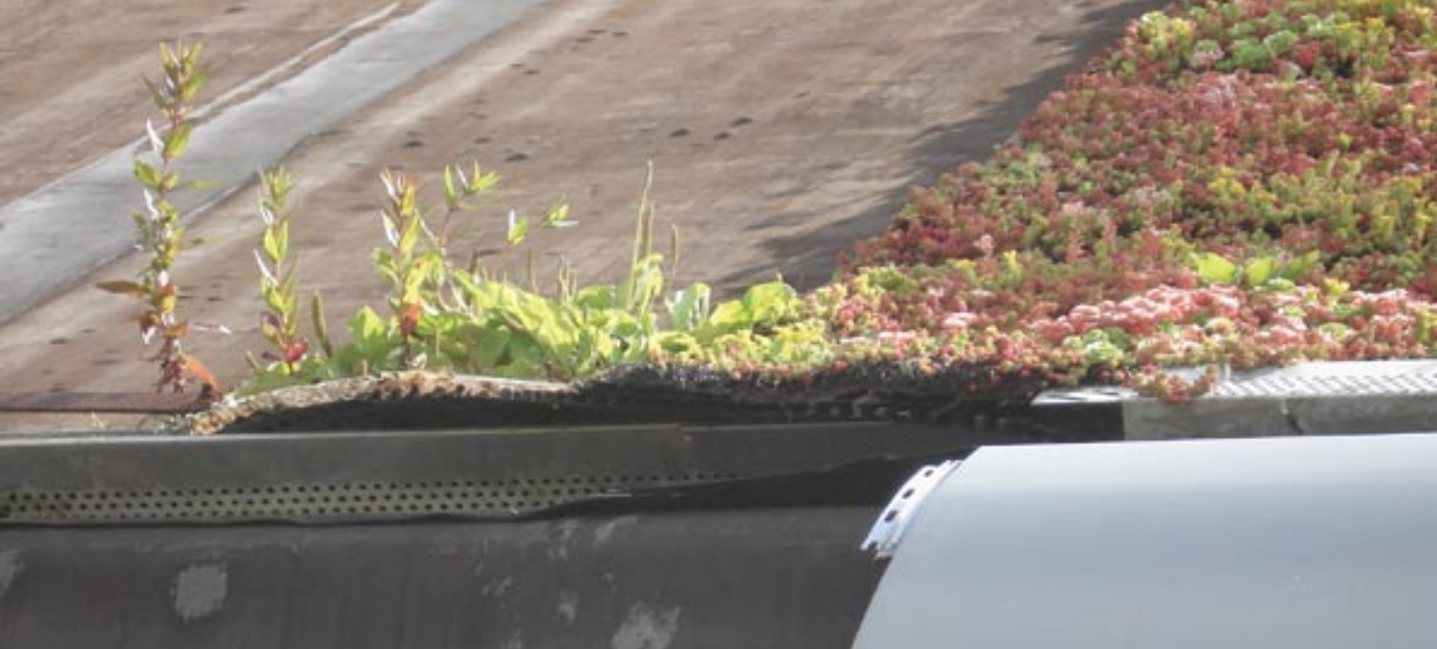
Figure III.11 e III.12: Stratigrafia di una copertura a verde estensivo collocata ad Amsterdam
