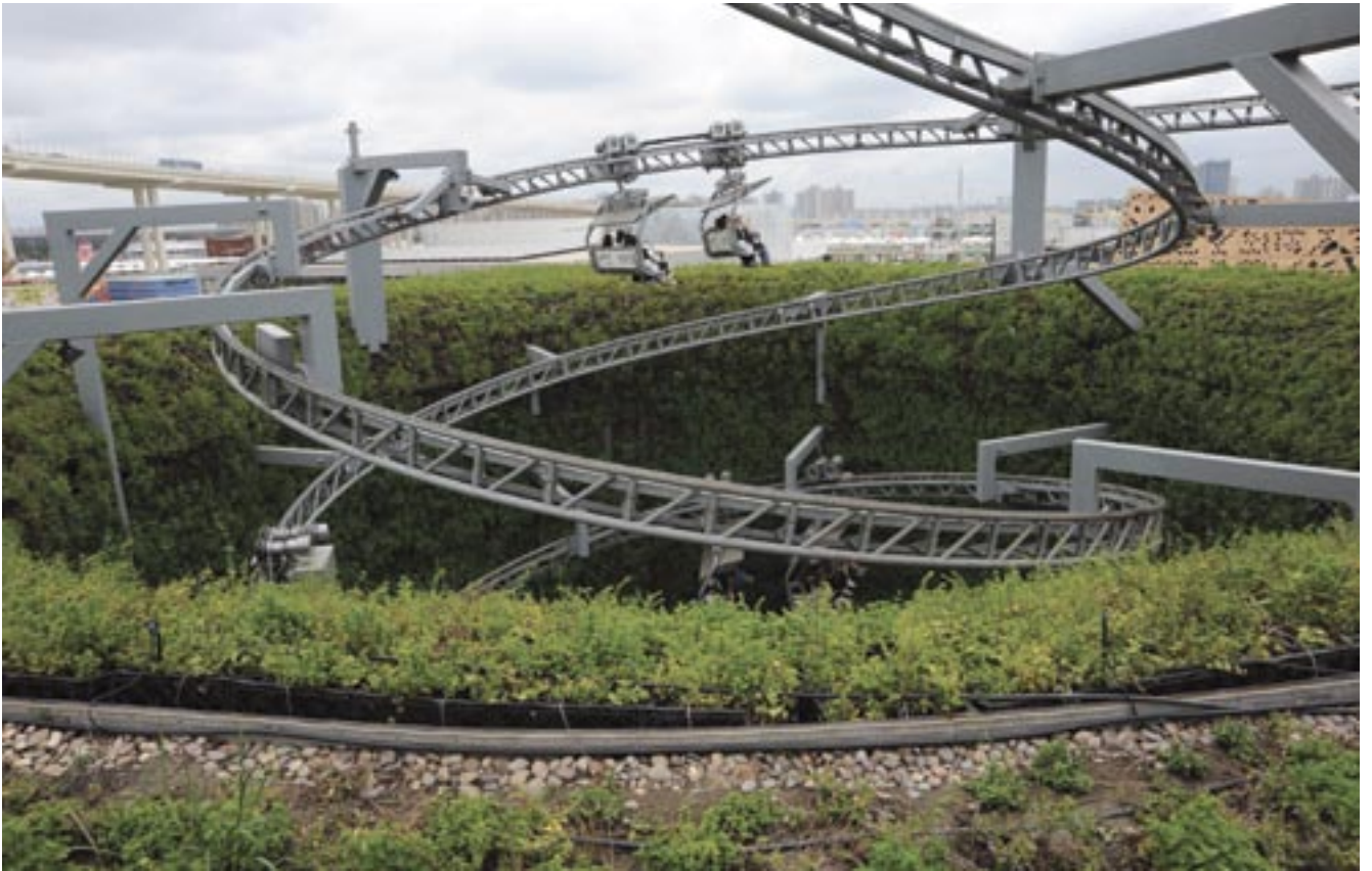
Figura II.7: Interruzione fra le due tecnologie a verde del padiglione
