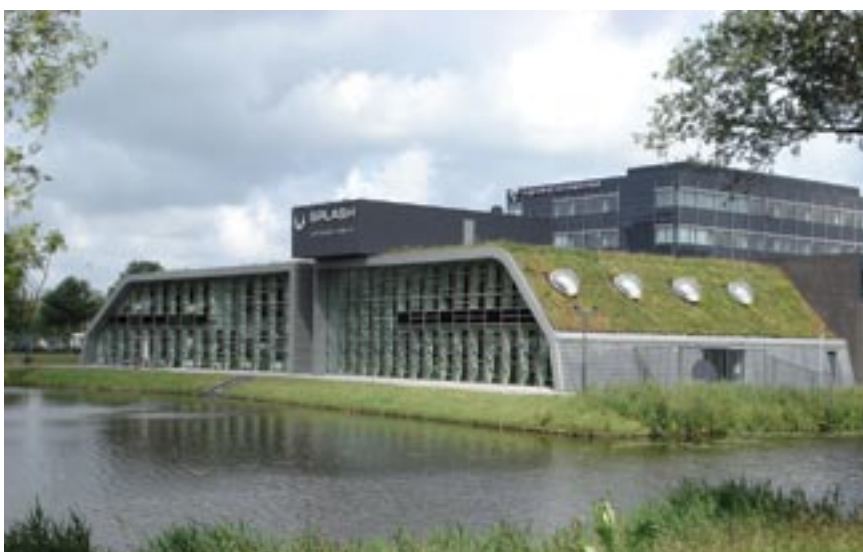
Figura III.13: Vista complessiva dell'edificio
