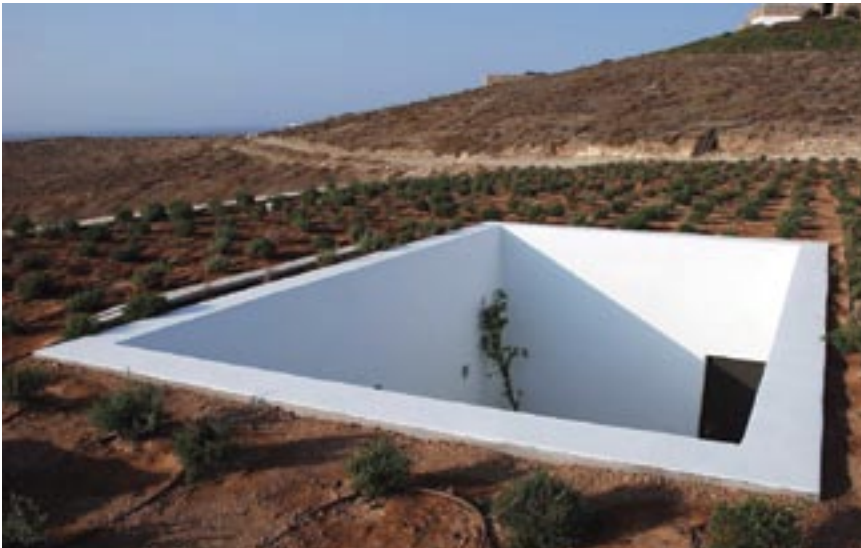
Figura III.24: Vista della chiostra dalla copertura
