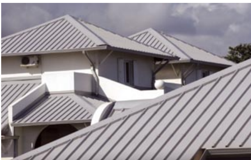
Figura I.42: Tetti a falda in lamiera
